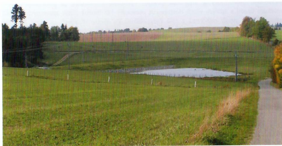
Protipovodňová retenční nádrž v k.ú. Němčice a k.ú. Žďár u Blanska
