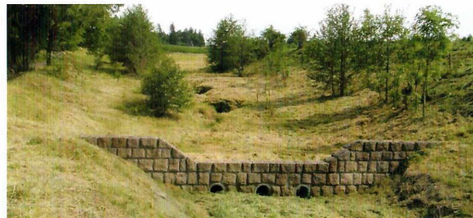
Protipovodňová přehrážka v k.ú. Lichnov
